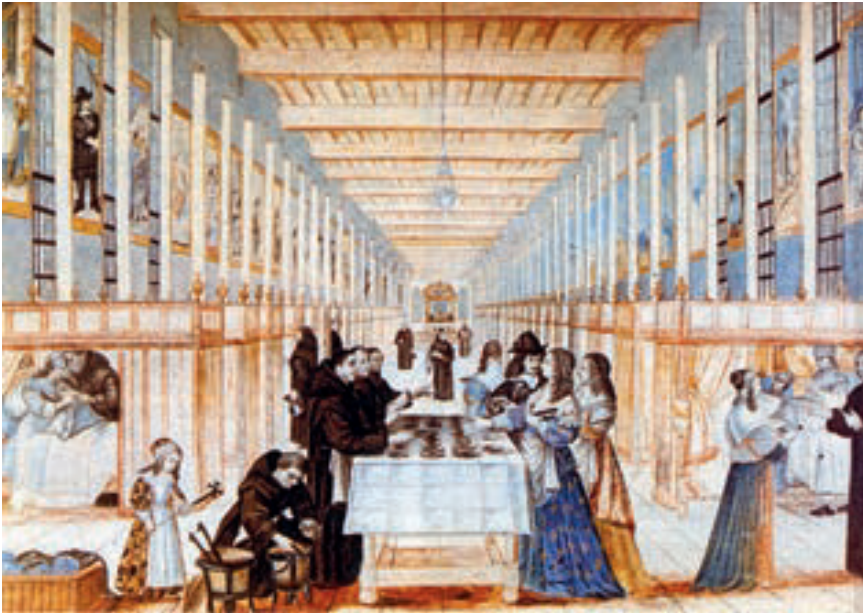
Hôpital de la Charité der Barmherzigen Brüder in Paris: Maria de' Medici hatte im Jahr 1600 den französischen König Heinrich IV. geheiratet und rief 1606 die Barmherzigen Brüder nach Paris. Der Hôpital wurde ab 1613 erbaut und war eines der prunkvollsten Hospitäler im Orden. Wie damals üblich durften hochgestellte Persönlichkeiten des Hofes bei der Ausgabe des Mittagessens bedienen. (Gemälde eines unbekanntes Künstlers nach einem Kupferstich von Abraham Bosse, 1602 bis 1676)
